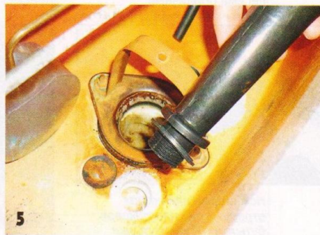
5 Теперь нужно прикрутить переливную трубку.
