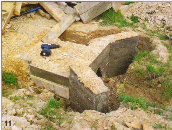
Сверху конструкцию засыпали опилками и поливали водой, чтобы бетон не пересыхал.
