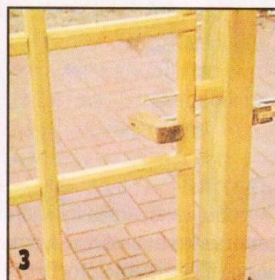
В качестве дистанционных элементов (проставок) подойдут и обрезки из отходов от распиливания решёток. В выкроенных проставках сверлят отверстия под шурупы.
