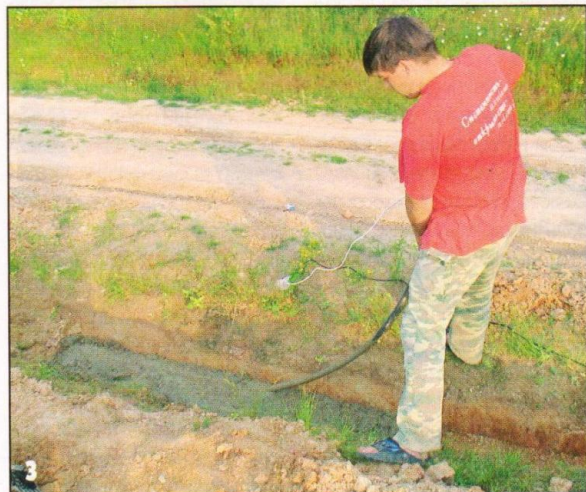
Бетономешалка и вибратор помогают качественно выполнять бетонные работы.
