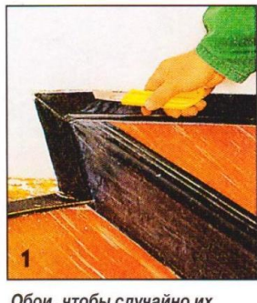
1 Обои, чтобы случайно их не повредить при удалении плинтусов, надрезают, проводя ножом по краю плинтуса как по направляющей.
