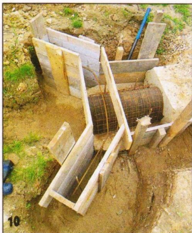
При наращивании трубы по длине сразу установили опалубку для заливки контрфорсов.
