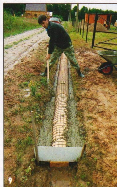
9 На заливку свода ушло несколько тачек бетона.
